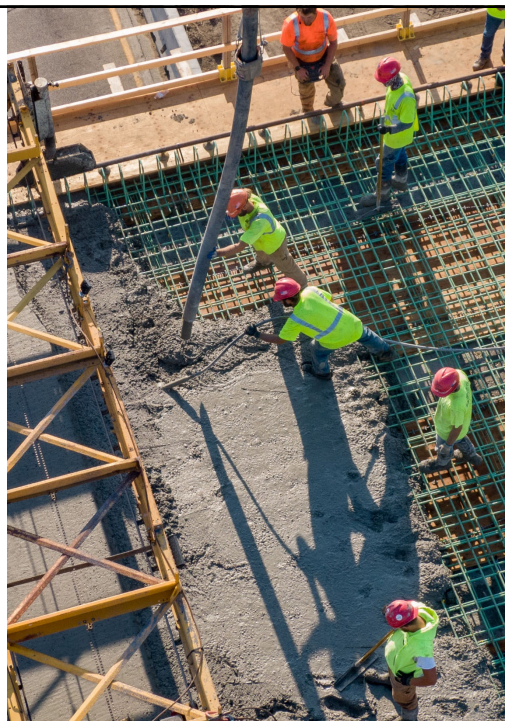
Bridge Deck Pour
